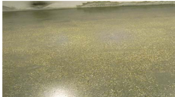
Grinding Korodur
